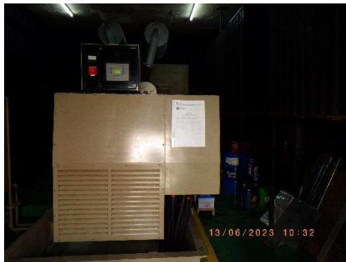
เครื่องกำเนิดพลังงานไฟฟ้าสำรอง และถังน้ำมันเชื้อเพลิง
