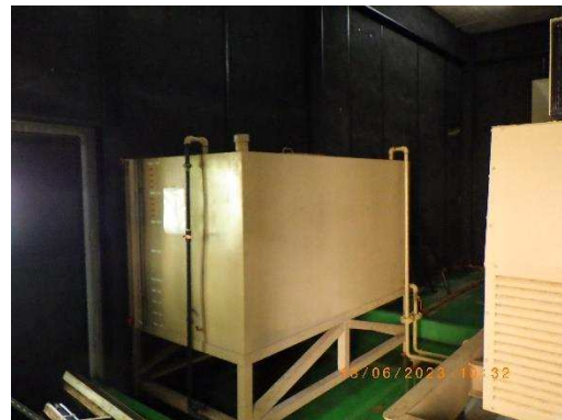
เครื่องกำเนิดพลังงานไฟฟ้าสำรอง และถังน้ำมันเชื้อเพลิง
